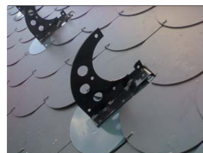
popis 6 Sněhový zachytávač křídlo č. 18 používaný do střešní krytiny Cembrit bobrovka s univerzální plotnou
