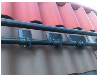
popis 8 Sněhový rozražeč používaný pro vlny A5, B8 najdete ho pod č. 77
