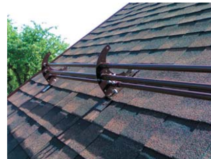
popis 12 Sněhový zachytávač křídlo č. 18 používaný do střešní šindelové krytiny s použitím tyče pod č. 28
