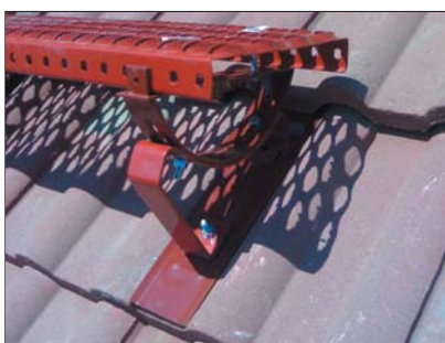
popis 2 Univerzální mezivlna č. 64 používaná s podpěrou stoupací plošiny č. 48 do všech druhů betonových krytin
