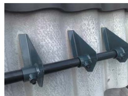
popis 9 Sněhový rozražeč používaný pro vlny A5, B8 najdete ho pod č. 77
