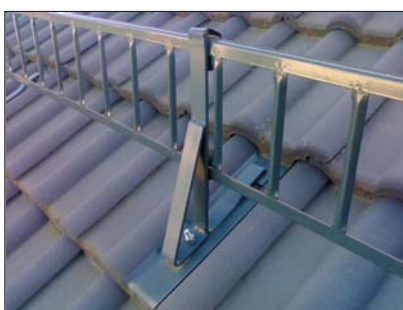
popis 5 Držák pro žebříček č. 31 používaný na univerzální mezivlnu č. 64 do všech druhů betonových krytin.
