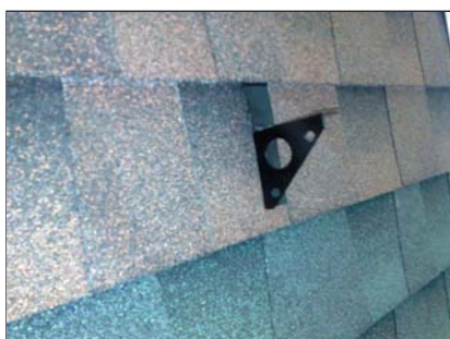
popis 10 Sněhový rozražeč (nos). Používaný do hladké krytiny Šindel.
